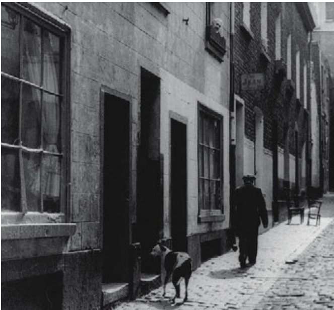
Slekkengang (Blaesstraat), 1952. Foto Albert van Ommeslaghe.
