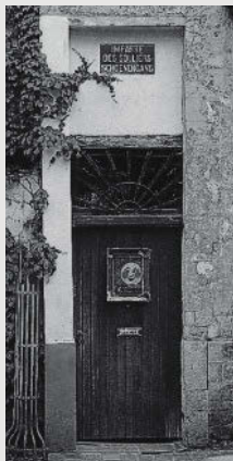
De Schoenengang (Huidevettersstraat) met zijn fraaie toegangsdeur.
